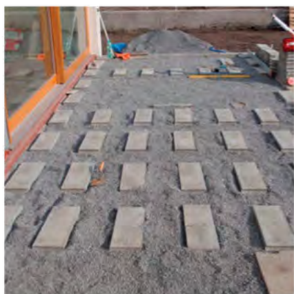
zhutnené štrkopieskové lôžko s betónovými podperami
