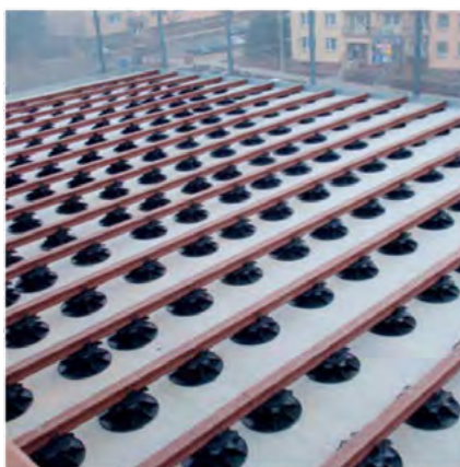
hydroizolácia alebo betónová doska
