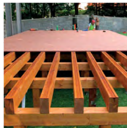
iná nosná konštrukcia
